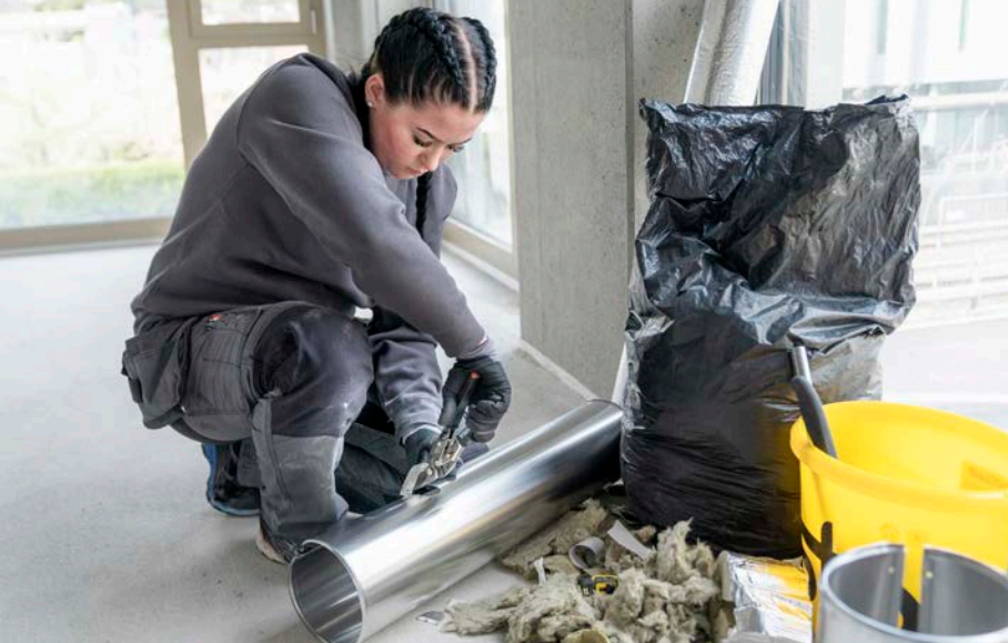
◀ Kyla Häcki schneidet mit der Bleischere eine Öffnung für die Aufhängung in ein Rohrteil.
